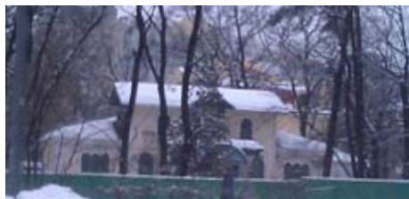
об'єкт культурної спадщини, будинок кінця 19-початку 20 ст. по просп. Перемоги, 130/1 станом на грудень 2013р.
